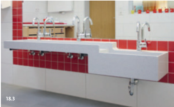
Unterfahrbare zweistufige Waschrinne für integrative Kita
